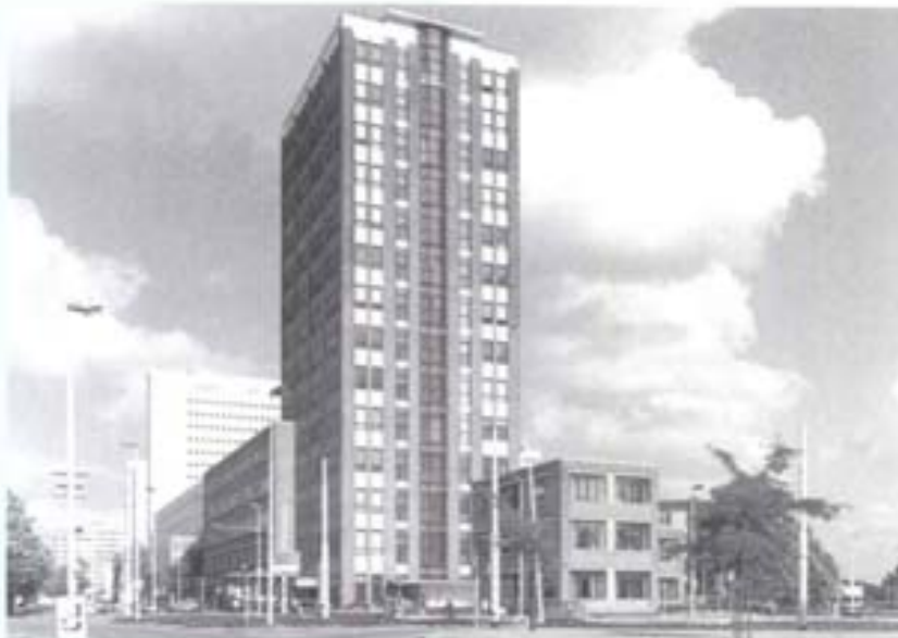
'Parkhaven', voormalig GEB gebouw Willem Buytewechstraat R'dam, alleen de draagconstructie is hergebruikt. Er zijn nieuwe gevels en twee lagen toegevoegd in dakopbouw.
