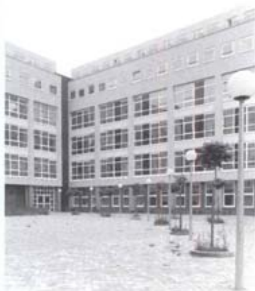
GEB-toren Rochussenstraat R'dam. Het gebouw is inclusief gevels, trappen en liften hergebruikt.
