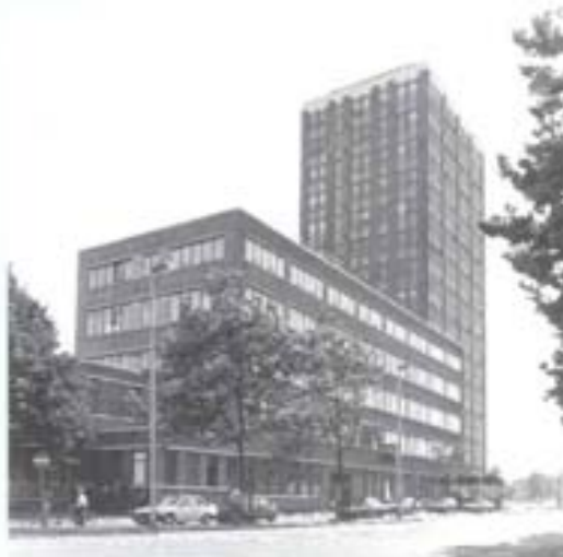
Voormalig kantoorgebouw GEB Rechussenstraat Rotterdam, nu wonen en 225 jongeren.
